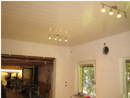
29.09.2014 Die Decke ist fertig.
